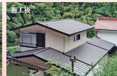
【施工事例】屋根の張替え補修
