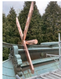
社寺等の屋根部分修理
