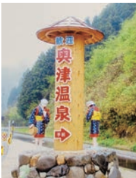
奥津温泉看板屋根施工
