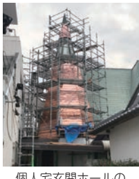
個人宅玄関ホール の屋根を銅板で施工
