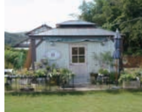
補助金を活用した店舗改修
